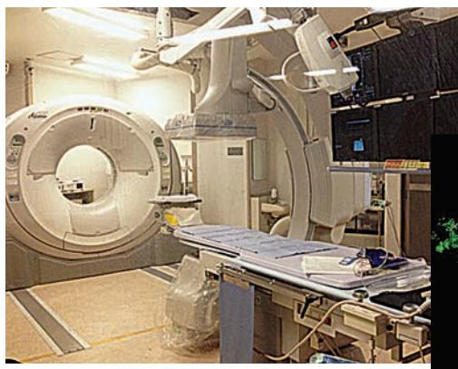
IVR-CT装置とは、X線により体内をリアルタイムで透視・撮影が出来る血管造影装置と、体内の精密な断層像(輪切りの写真)が得られるCT装置が一体となったもので、ベッドに寝た状態のまま、血管造影とCTの2つの検査が出来る装置です。2つの検査を組み合わせる事で、病変の診断だけでなく、治療支援装置としても使用することが可能となり、主に肝臓癌のカテーテル治療の際に用いられます。
